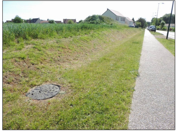
Talus routier le long de la rue Bad Zwesten
